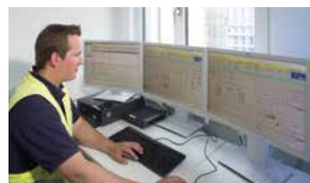
Hình 7. Phòng điều khiển tự động của Energiepark Mainz [4].
