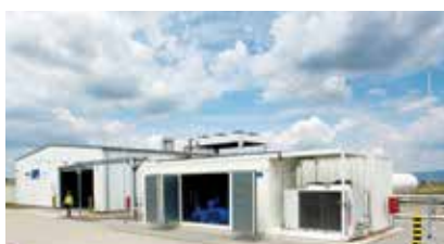
Hình 4. Container máy nén hydrogen xanh [4].
