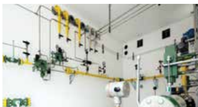
Hình 6. Nạp khí hydrogen xanh vào hệ thống dẫn khí đốt tự nhiên [4].
